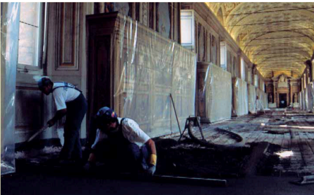
Extensión y acabado del recrecido confeccionado con Mapecem - Salones Sixtinos - Ciudad del Vaticano
