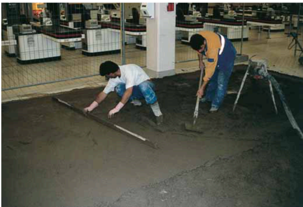
Reparación rápida del recrecido en un supermercado
