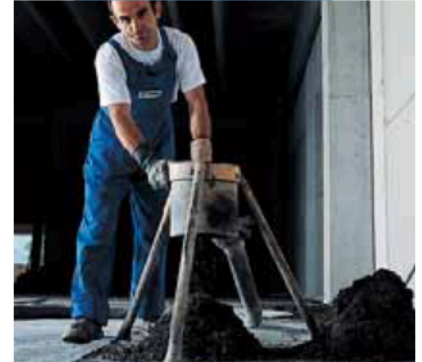
Suministro de la mezcla confeccionada con Mapecem
