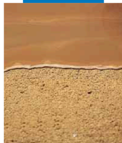
Acabado del recrecido realizado con Mapecem con Ultraplan autonivelante
