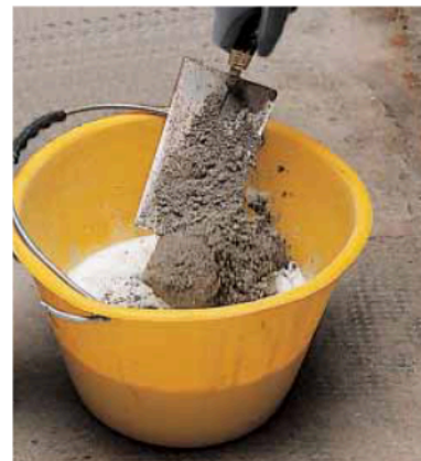
Mezcla de Mapecem con Planicrete como lechada de adherencia
