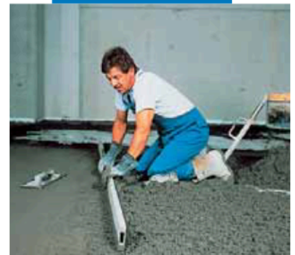
Extensión de la mezcla confeccionada con Mapecem
