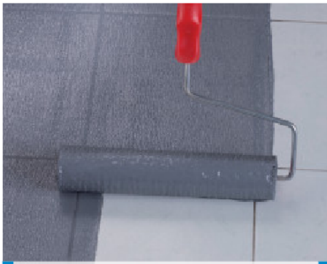
Aplicación a rodillo de Eco Prim Grip Plus sobre pavimento existente de losetas de gres porcelánico
