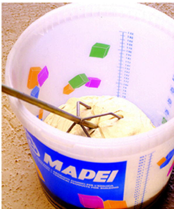
Mezcla de Mapeset con agitador mecánico
