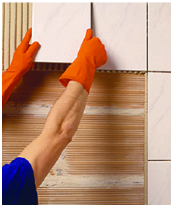
Colocación en pared de revestimiento cerámico
